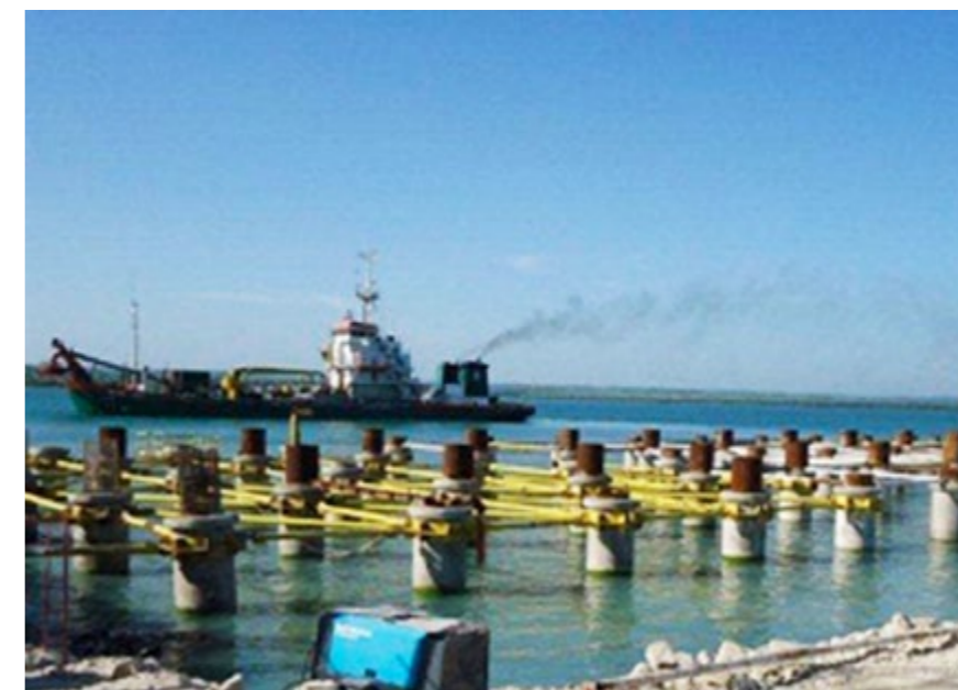
Avanza la construcción del puerto de El Mariel.
