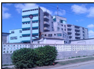
Chimenea del Hospital Mario Muñoz
