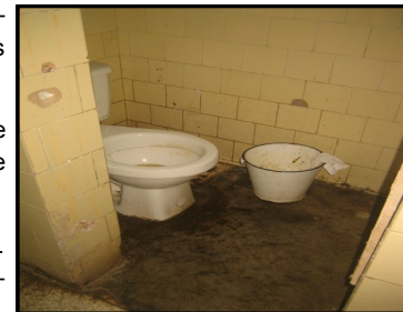
Baño del Hospital municipal de Cárdenas
