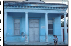
Tienda de venta de materiales de la construcción "La Flota"
